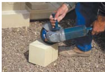
Taglio dei cubi di appoggio per la scala
