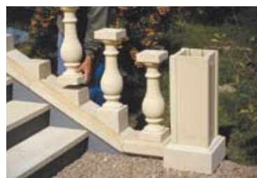
Posa dei balaustri sul montante della scala.
